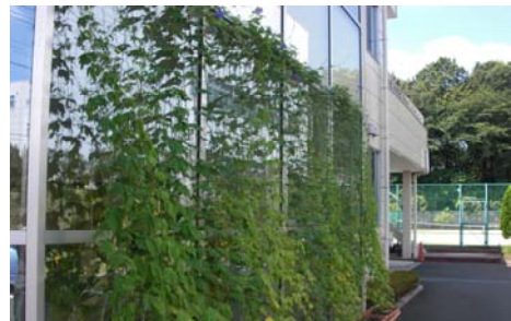
グリーンカーテン設置
